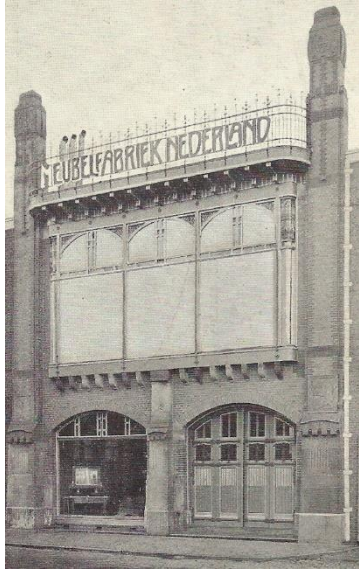
Fabriekspand, Blekerstraat, Groningen
